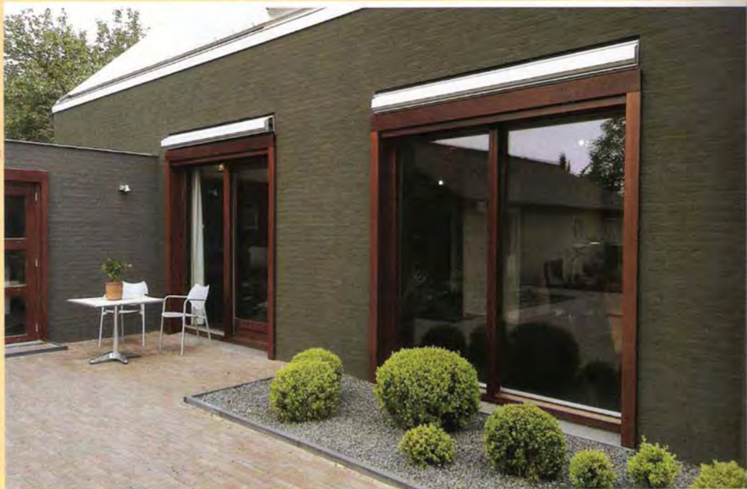
Bij de 'binnenplaats' blijkt hoe mooi de zonweringen in de kozijnen zijn opgenomen.
