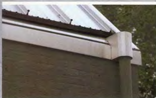
Een charmant detail van het aluminium dak met oplossing voor waterafvoer
